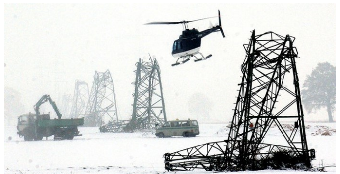
Tägelanger Blackout 2005 in Münsterland Deutschland wegen umgeknickter Hochspannungsmasten. (www1.wdr.de/fernsehen)
