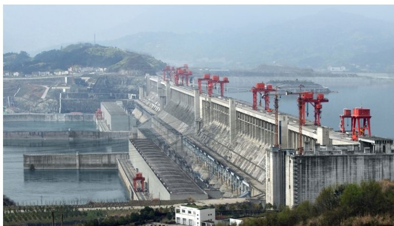
Drei-Schluchten-Talsperre (Three Gorges Dam) in China mit mehr als 22 GW Leistung, ist ernsthaft beschädigt und könnte einstürzen. ( https://www.britannica.com/topic/Three-Gorges-Dam )
